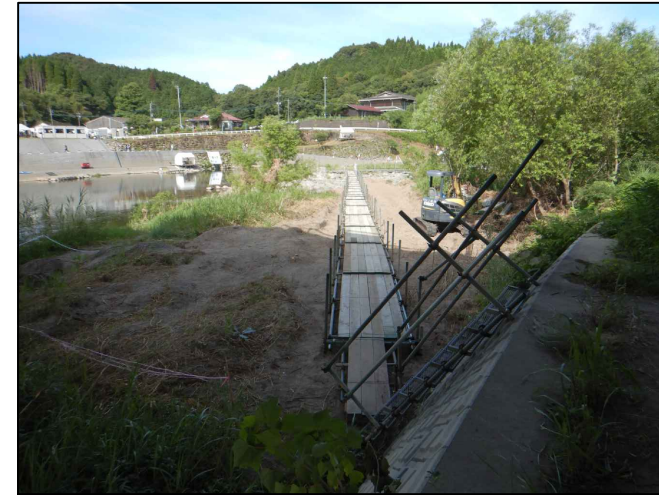
(参考) 仮設通路
