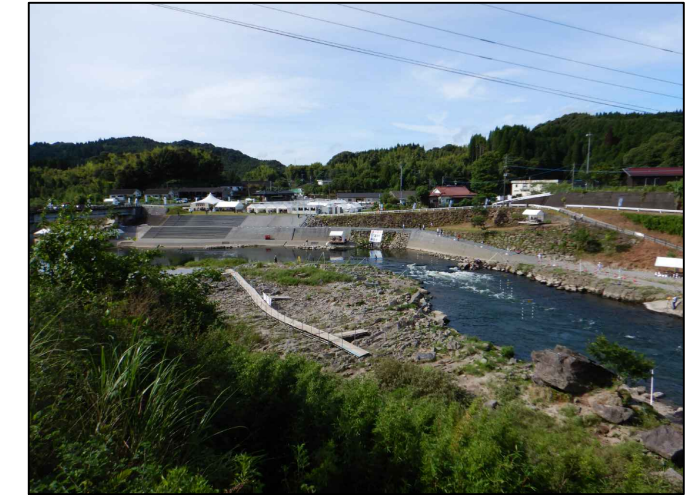
(参考) 仮設通路
