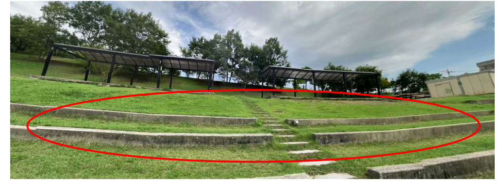
架台設置箇所
