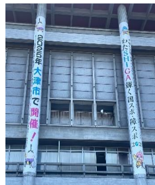
大津市役所 建物正面壁面柱
